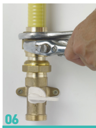
06 Terminer le serrage en butée
